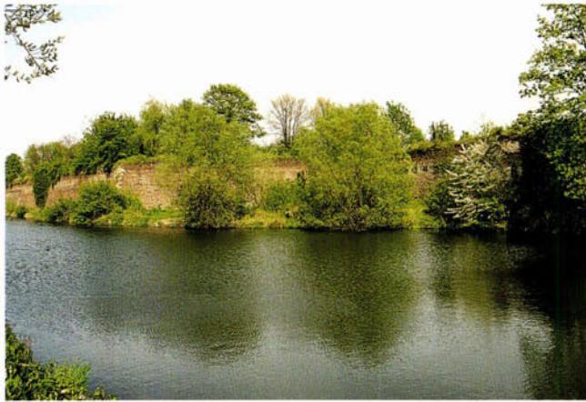
FIGUUR 3 Deel van de Lage Fronten: de gracht met de escarpe in 2000 (foto: R. Tilmans).
